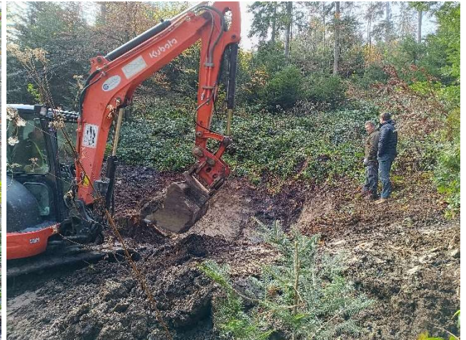
Slika 18: Nadzor ob izkopu
