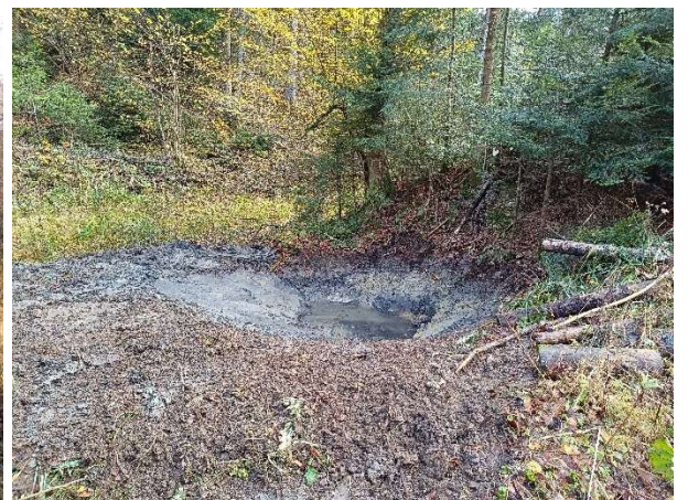
Slika 22: Mlaka ob zaključku izkopa
