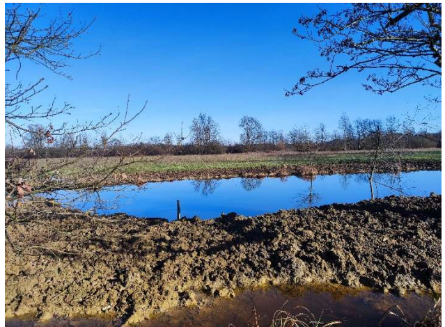
Slika 12: Mlaka tipa A (mlaka št. 7) napolnjena z vodo po izkopu
