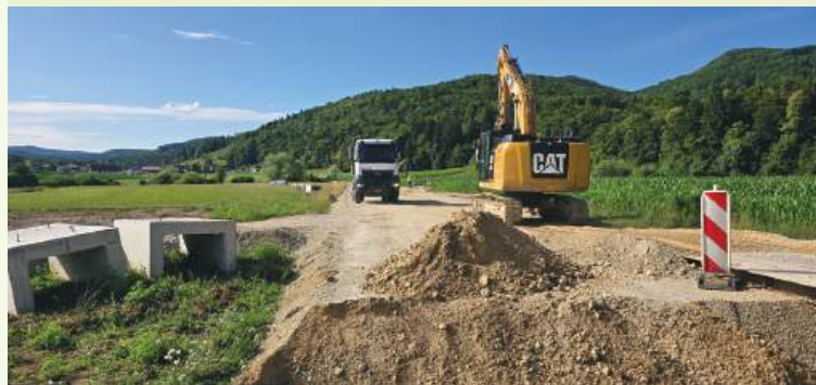
Izkop materiala za vgradnjo podhoda
